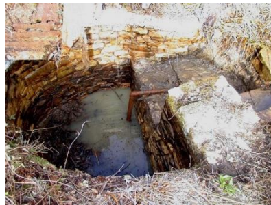
Le puits dégagé
